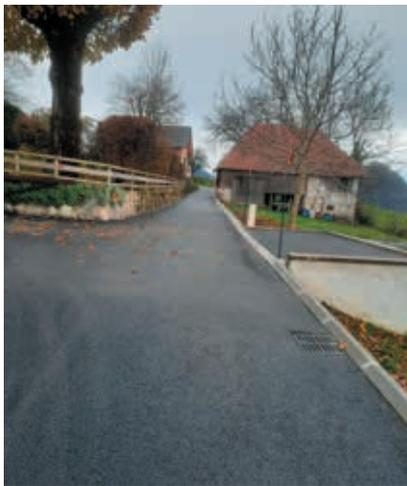
Au cours de l'automne 2022, au hameau du Noiray, réfection du chemin Philippe Chauland qui dessert plusieurs habitations et une grange. Le mur de soutènement en mauvais état a été refait avec traitement des eaux pluviales par infiltration et mise en place d'un tapis en enrobé.
